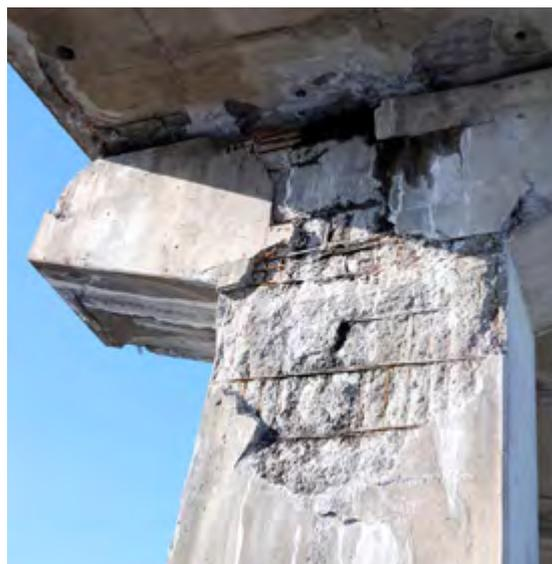
Figura 02: Concreto fragmentado.
