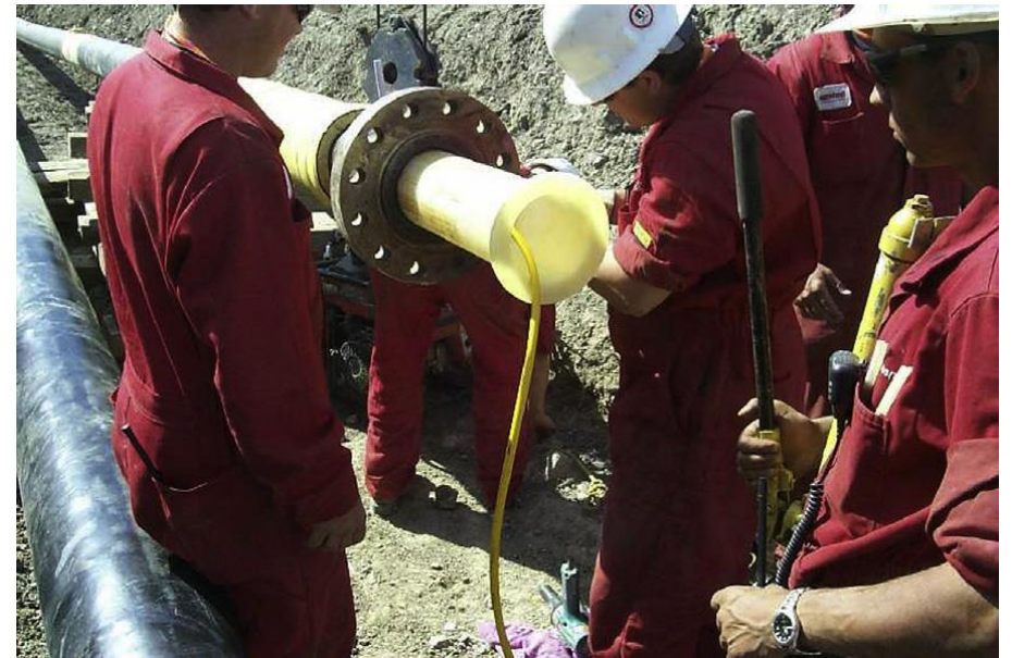
Instalação de liner
