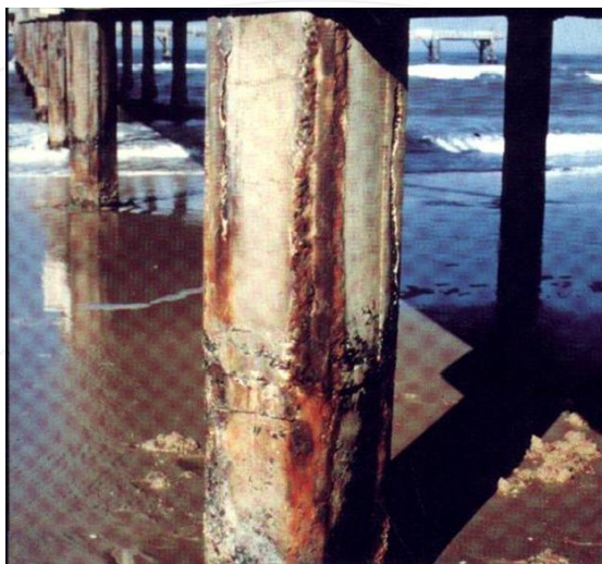
Figura 06 – Estaca de concreto armado com manchas de corrosão.
