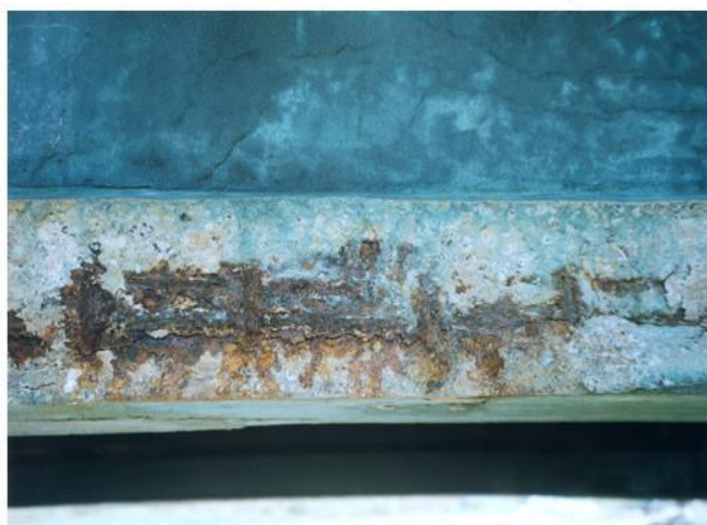
Figura 02 - Laje de concreto (A) e costado de tanque em concreto (B) com presença manchas de eflorescências e com formação de estalactites resultantes da lixiviação de compostos do cimento e de sua reação química com o CO 2 atmosférico e com a presença de manchas de lixiviação de produto de corrosão.
