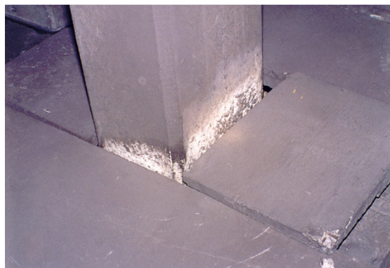
Fig. 05 – Pilar de concreto, com manchas de eflorescência na parte inferior e com desagregação com exposição do agregado
