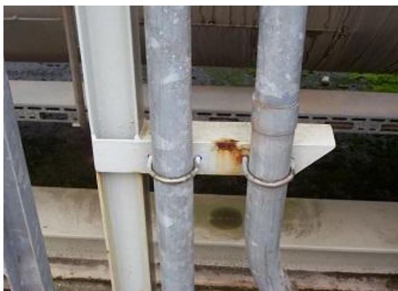
Fig. 03 - Apoios de tubulações com abraçadeiras (Cortesia IEC Engenharia)
