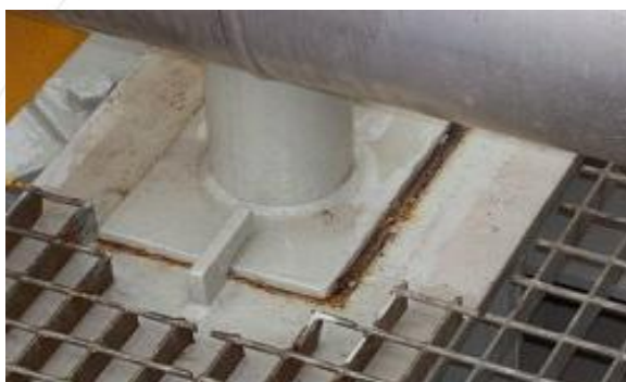
Fig. 01 - Apoio de estrutura
