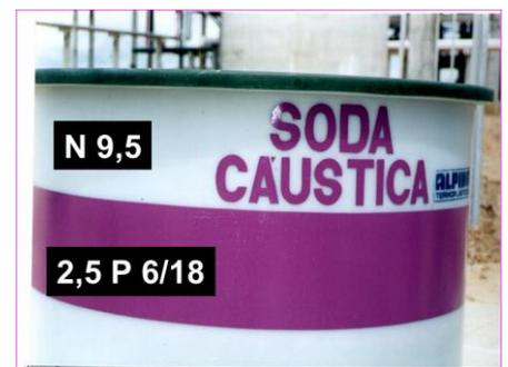
*Figura 35 – Faixa lilás que identifica o tanque de álcali (soda caustica). Álcali – produto alcalino (10)*
