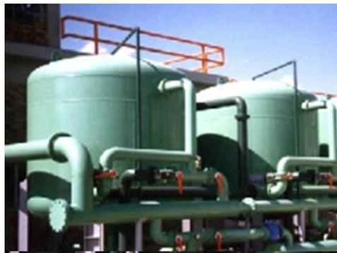
*Figura 31 – Verde na pintura de tanques e tubulações de água (10)*
