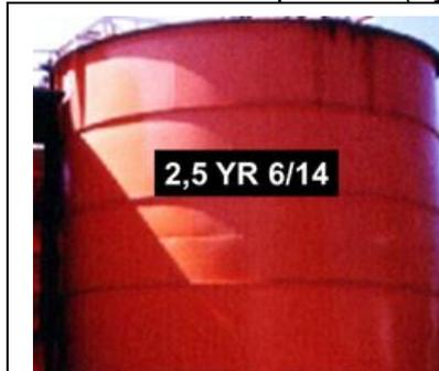
*Figura 33 – Cor laranja identificando um tanque de produtos químicos (ácido) (10)*
