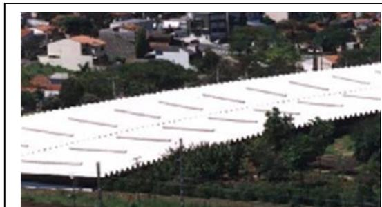
Figura 47 – Pintura de telhados com a cor branca para diminuir o aquecimento (10)
