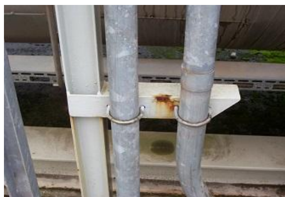
Fig. 03 - Apoios de tubulações com abraçadeiras (Cortesia IEC Engenharia)
