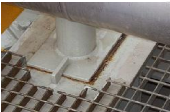
Fig. 01 - Apoio de estrutura (Cortesia IEC Engenharia)
