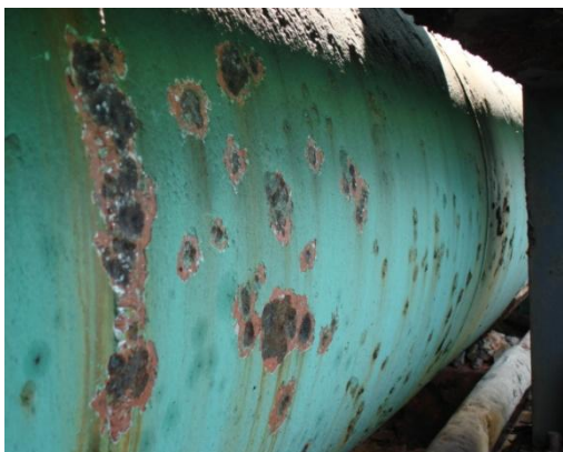
Fig. 07 – Reparo de campo em pintura de tubulação com pites/alvéolos (Cortesia IEC Engenharia)
