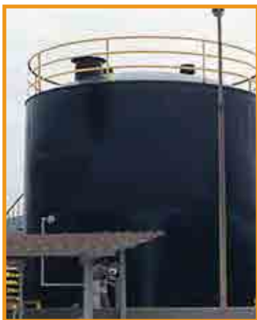
Figura 14 – Pintura de tanque de óleo combustível com acabamento preto (N 1) para aquecer o produto, facilitar bombeamento e economizar energia
