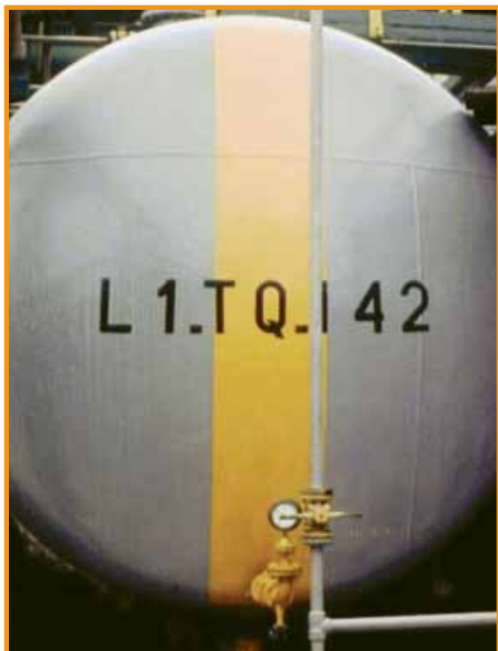
Figura 16 – Pintura de tanque de ácido sulfúrico com tinta cinza clara e faixa laranja
