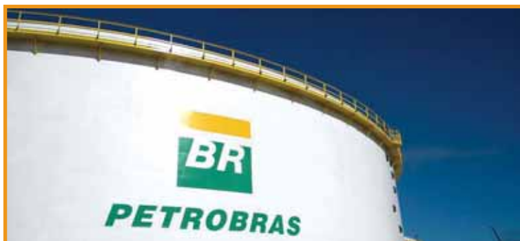
Figura 15 – Pintura de tanque de fração leve de petróleo com acabamento branco (N 9,5) para diminuir o aquecimento do produto e minimizar perdas por evaporação
