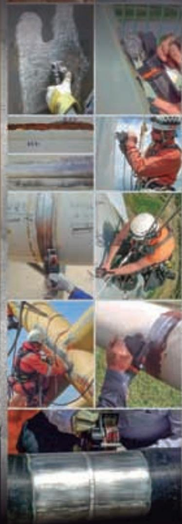
O "jato" é executado por cerdas especiais que impactam na superfície na mesma velocidade que um abrasivo. Disponível para aço carbono ou inox. Por não fazer atrito sobre o metal, não existe geração de calor. Índices baixos de ruído e vibração garantem maior produtividade e conforto.
