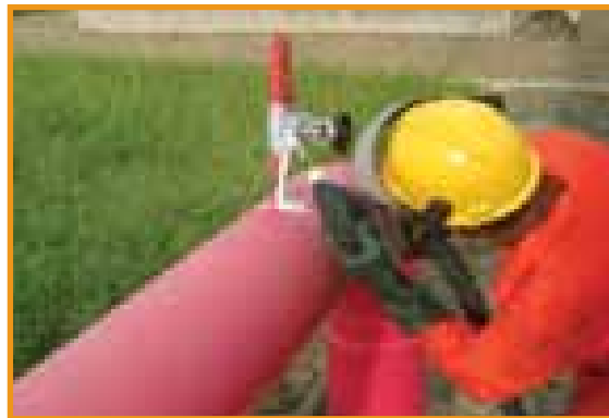
Figura 4 – Aplicação do polímero termoplástico em válvula
