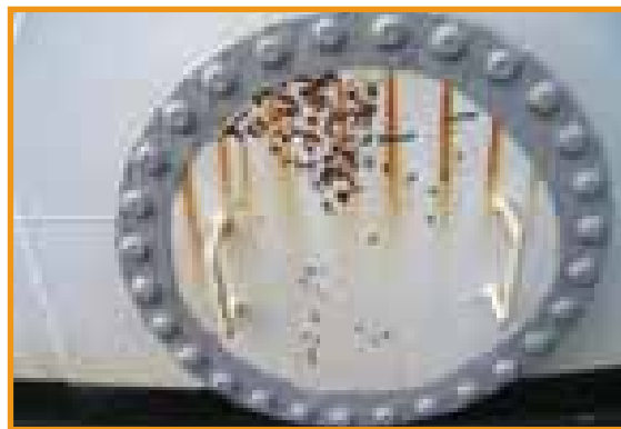
Figura 6 – Bocal de visita da torre de resfriamento após revestimento
