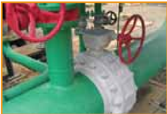
Figura 7 – Válvula e flange revestidos com polímero termoplástico
