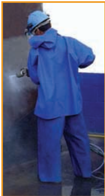
Figura 2 – Hidrojateamento à alta pressão em conjunto com abrasivo
