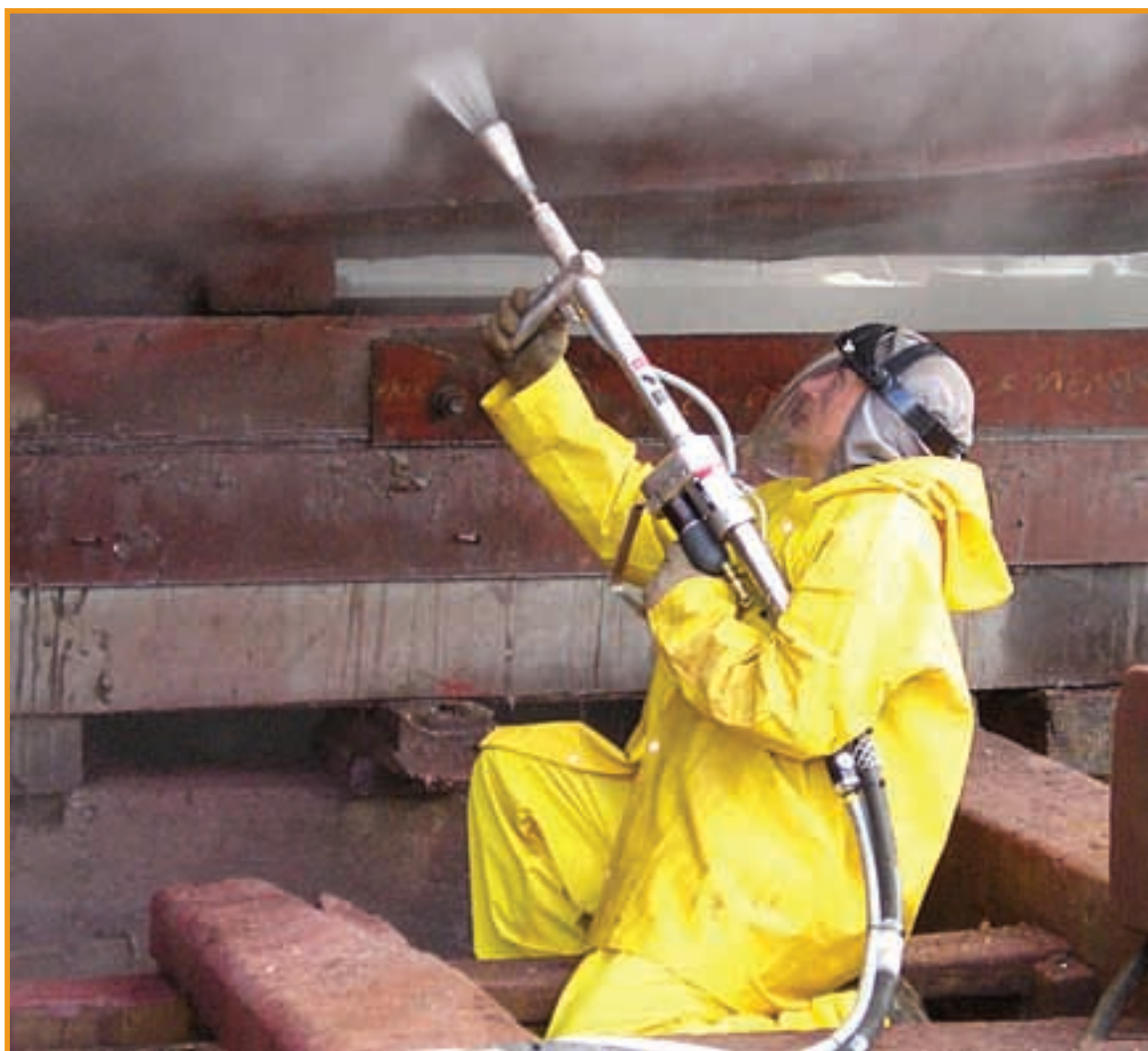
Figura 1 – Hidrojateamento à alta ou superalta pressão
