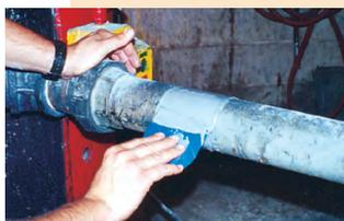
Vazamentos, por menor que sejam, é um dos principais problemas das equipes de manutenção. Um vazamento na linha de produção
