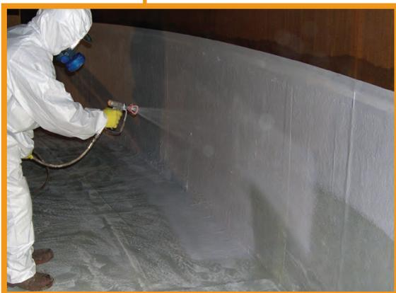
Aplicação de revestimento qualificado conforme norma N1201 da PETROBRAS
