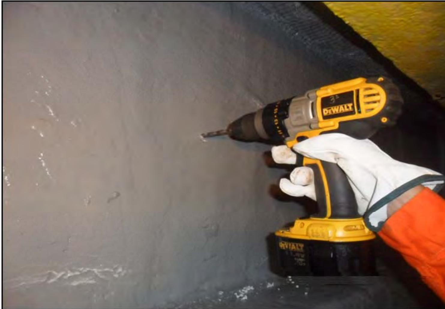
**Execução de Furo para Medição de Espessura Seca**
