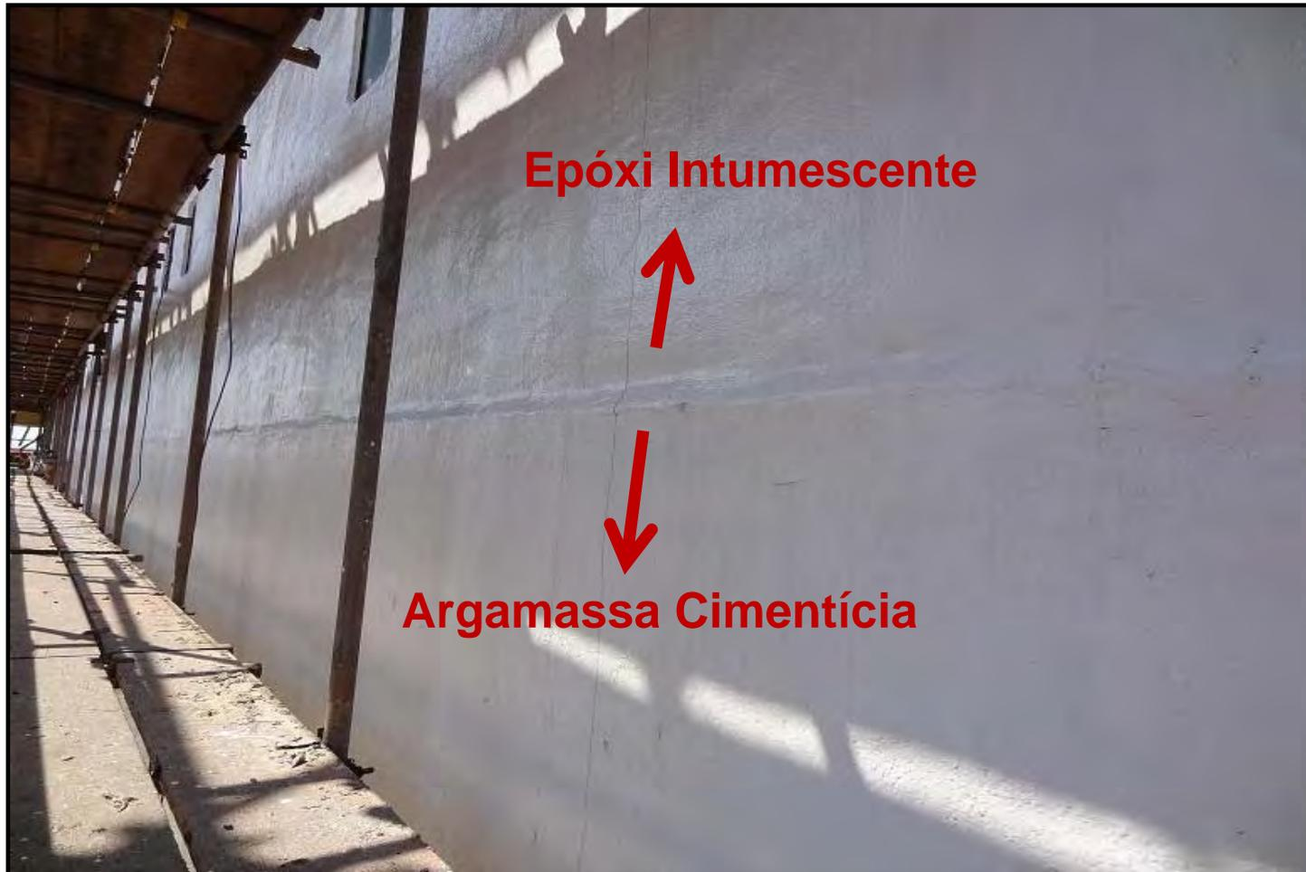
**Antepara com Epóxi Intumescente na Parte Superior e Argamassa Cimentícia na Parte Inferior**
