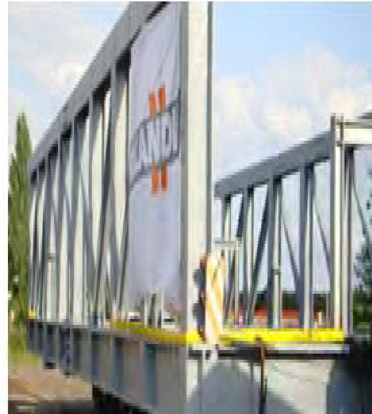
**Seção de Módulo Estrutural Revestido com Epóxi Intumescente sendo transportado para Embarque**
