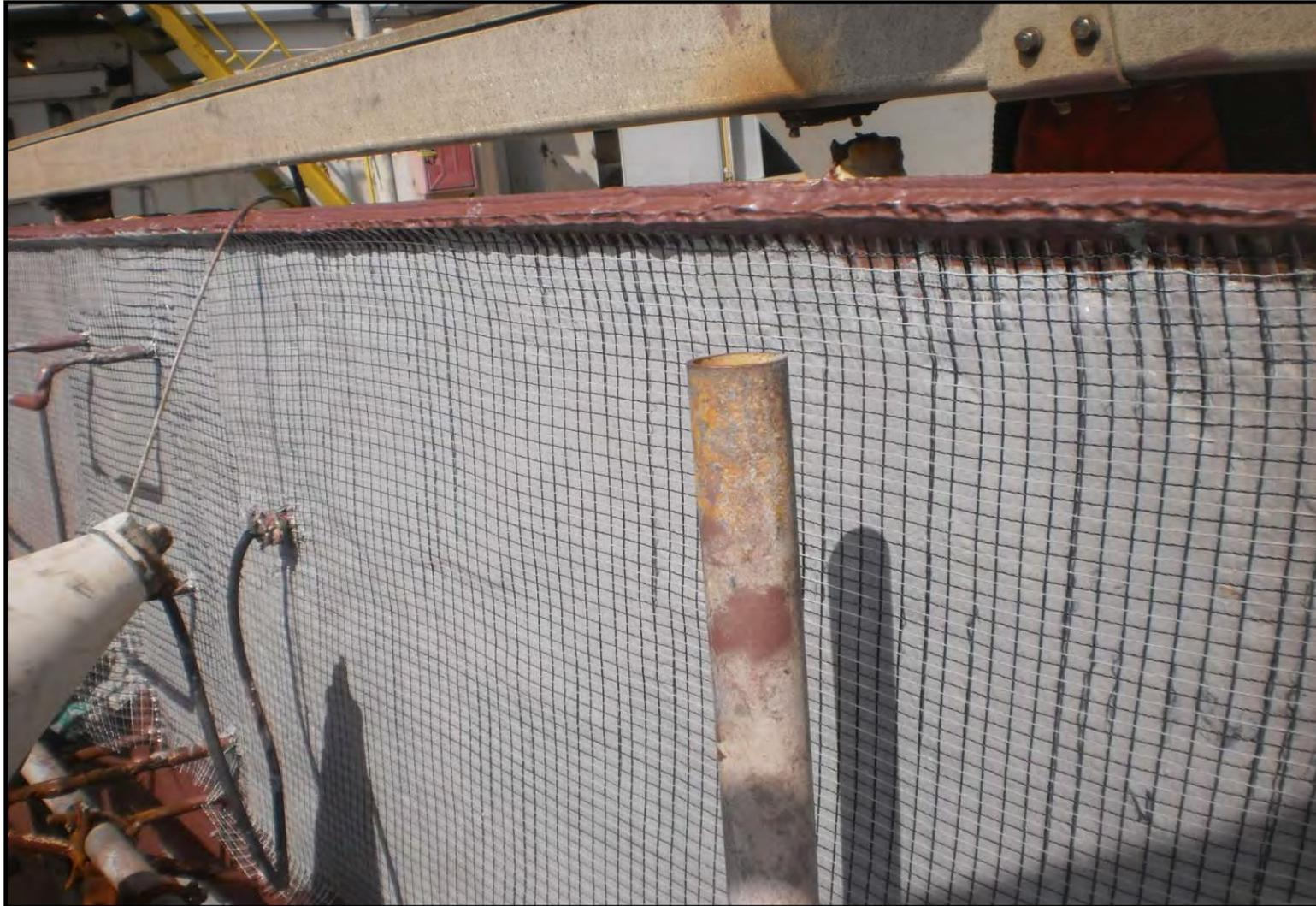
**Aplicação da Malha sobre a 1ª Metade do Epóxi Intumescente**
