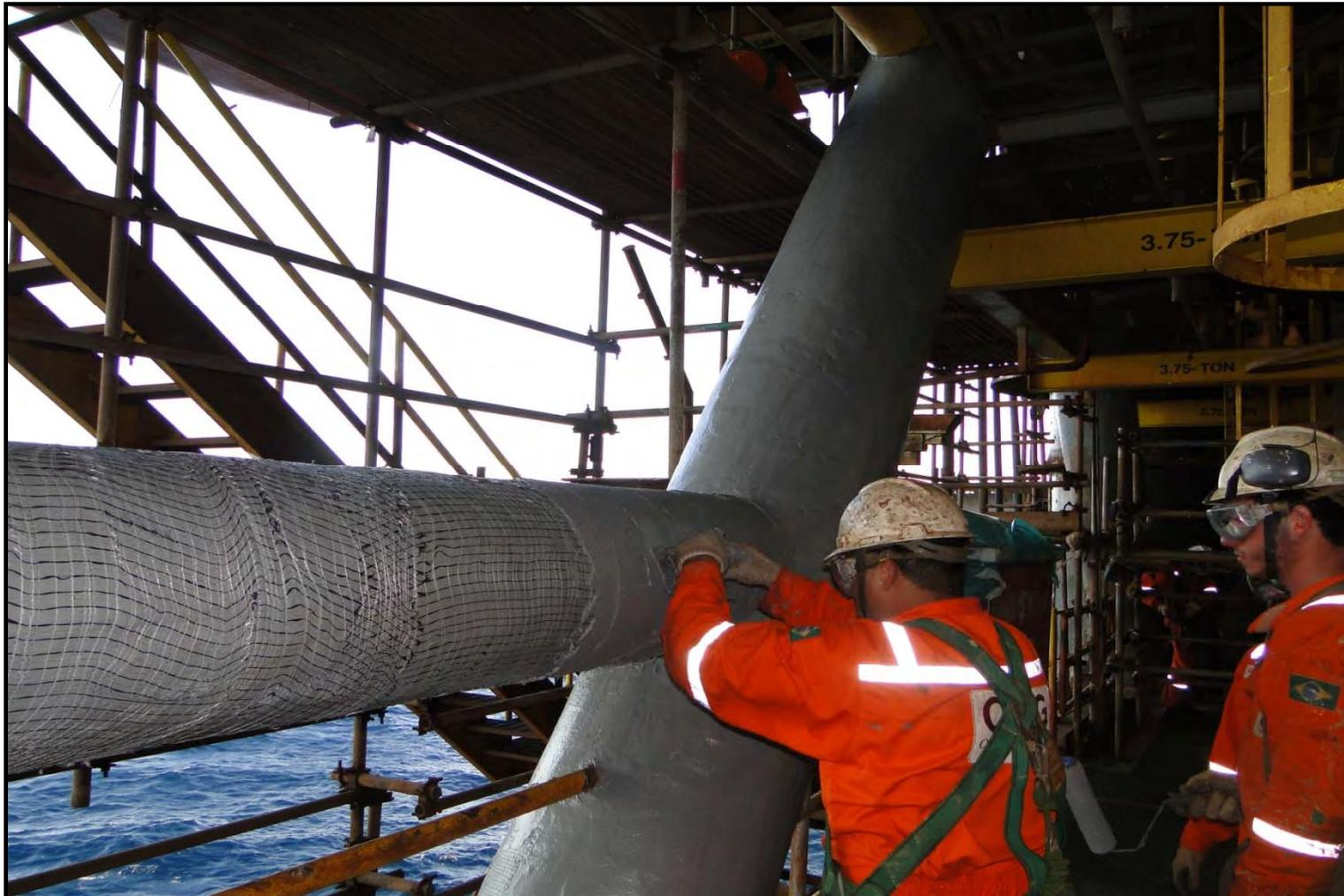
**Aplicação da 2ª Metade do Epóxi Intumescente com Desempenadeira sobre a Malha da Coluna Estrutural**
