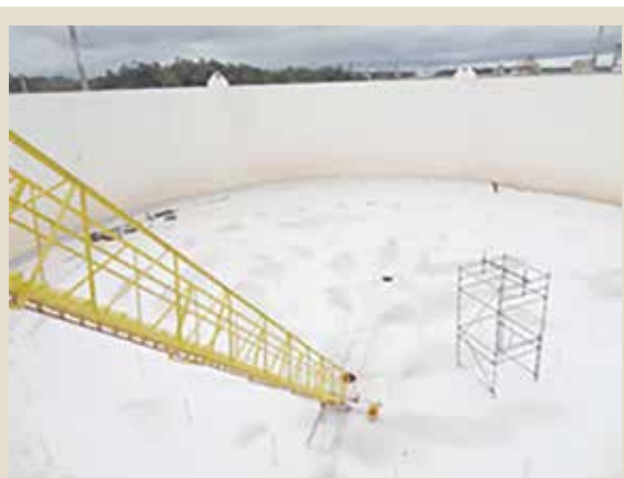
Pintura de costado interno, teto flutuante e escada de um tanque
