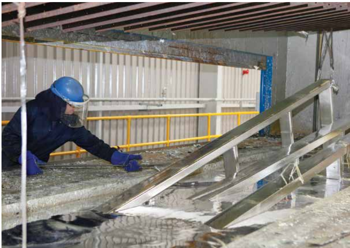
Figura 1: Estrutura metálica sendo imersa em um banho de zinco.
