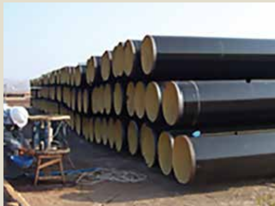
Pintura interna de tubos
