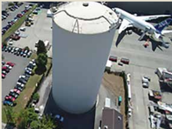
Pintura externa de um tanque de água para incêndio em um aeroporto
