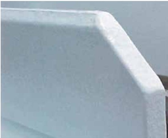
Figura 15 - Estruturas pintadas com as bordas arredondadas (maior vida útil sem corrosão)
