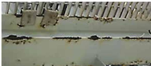
Figura 3 - Corrosão nas arestas vivas de uma Viga de aço
