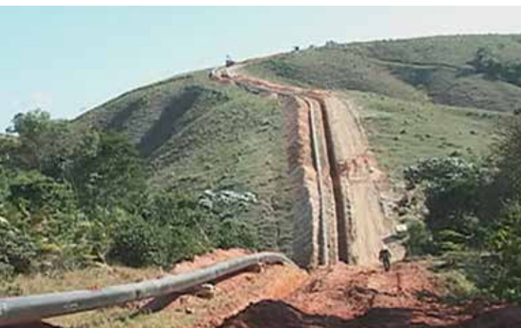
Fig. 01 - Tubulação de gás enterrada em fase de construção
