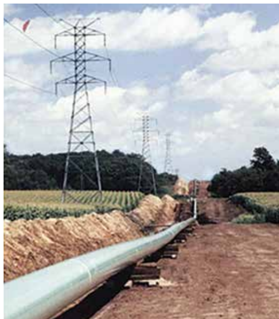
Fig. 05 - Tubulação de aço enterrada em fase de construção na mesma faixa de servidão de uma linha de transmissão elétrica em alta tensão.
