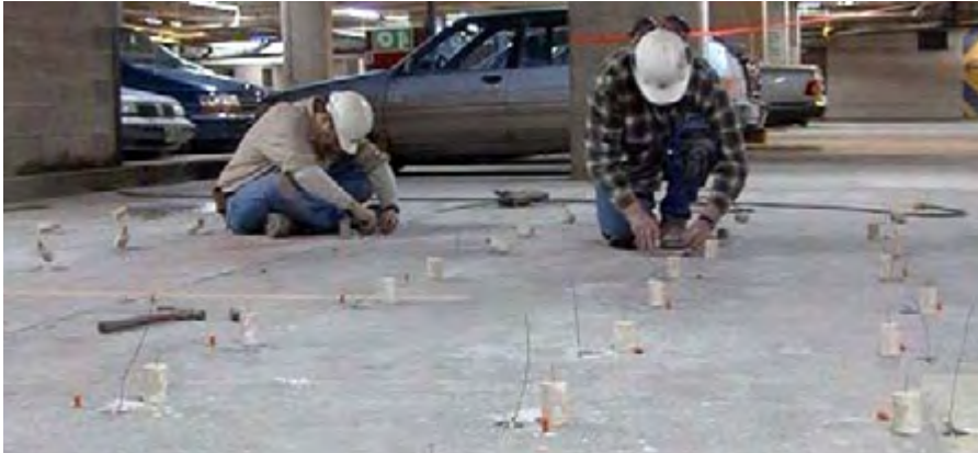
Figura 14 - Instalação de anodos em laje - Fonte: Vector Corrosion, 2019
