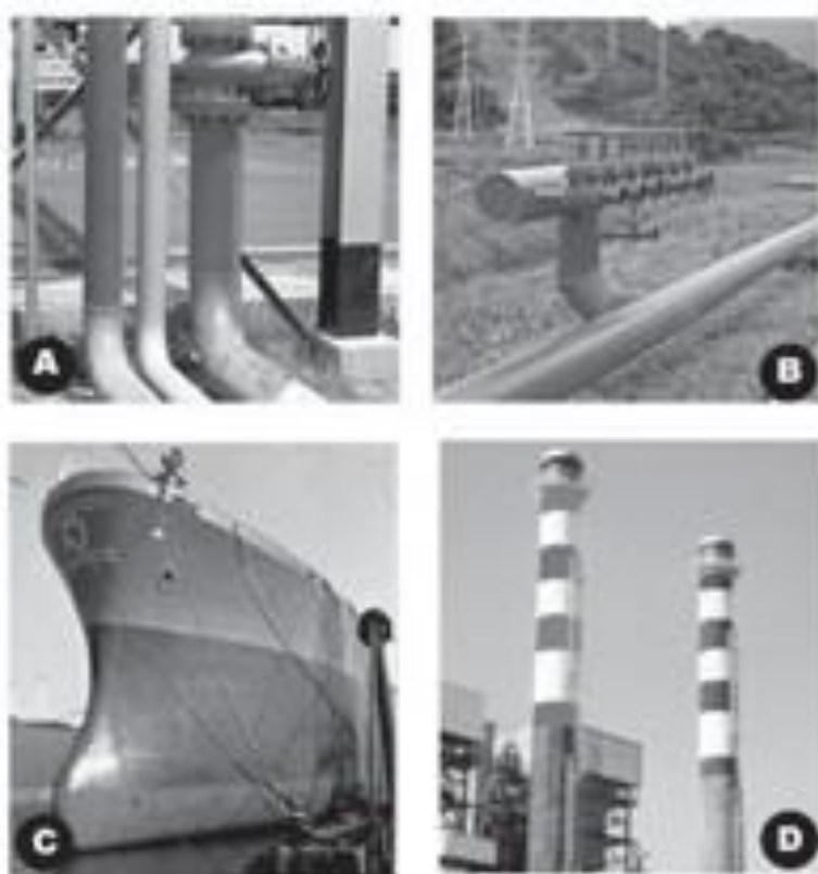
Figura 1. Diferentes campos de aplicação da pintura. A) proteção anticorrosiva e identificação de linhas de fluídos; B) pintura anticorrosiva e identificação de linha de água de incêndio; C) pintura antiincrustante em casco de navio; D) pintura em chaminés, para sinalização aérea.
