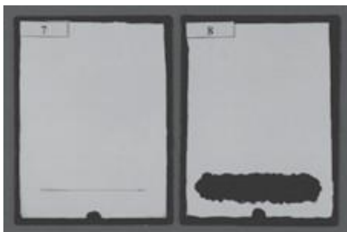
Figura 11. Desempenho à corrosão de esquemas de pintura, após 43 meses de exposição em atmosfera industrial: (7) esquema com tinta de fundo epóxi pigmentada com zinco (8) esquema com tinta de fundo epóxi pigmentada com óxido de ferro vermelho
