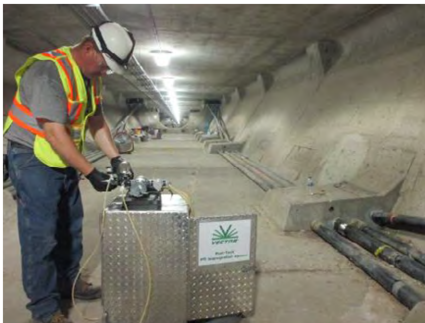
Figura 11: Serviços de Investigação dos Problemas de Corrosão em Cabos Pós-Tensionados
