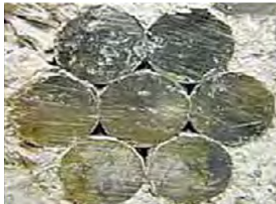
Figura 4: A Injeção da Resina Polimérica é Feita nos Interstícios dos Cabos de Protensão
