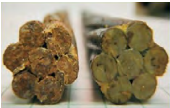
Figura 9: Amostras de Cabo Não Tratadas e Tratadas com o Material de Impregnação
