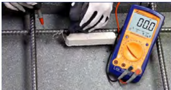
Figura 1: Instalação de Anodo de Proteção Catódica para a Proteção Contra a Corrosão de Armadura de Aço de Estrutura de Concreto ou Cabos Pré-Tensionados
