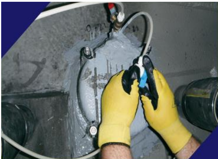
Figura 7: Impregnação Sendo Feito na Extremidade do Cabo Pós-Tensionado
