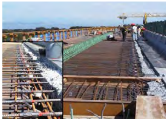
Figura 2: Anodos de Proteção Catódica em Fase de Instalação em uma Ponte
