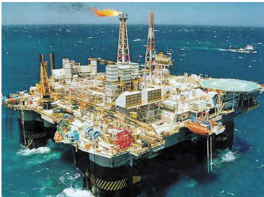
Fig. 03 - As plataformas flutuantes, incluindo as FPSOs (Floating Production Storage and Offloading), são protegidas por sistemas de proteção catódica do tipo por corrente impressa, conforme DNV-RP-B101 e DNV-RP-B401, sendo que a proteção interna dos tanques pode ser feita com anodos galvânicos de Alumínio (ABNT NBR 10387) ou Zinco (ABNT NBR 9358).
