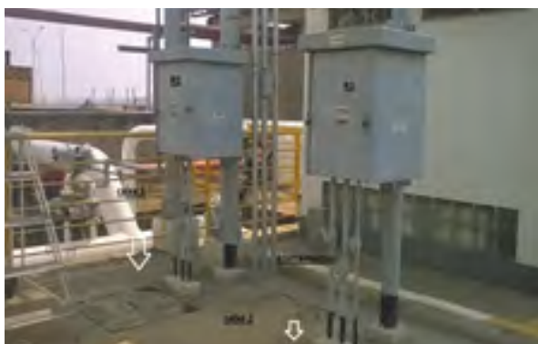
Fig. 15 – Tubulações enterradas em plantas industriais, como a redes de combate a inocência, água de refrigeração, gás e outros produtos, estão sujeitas a problemas graves de corrosão devido, principalmente, à presença da malha de aterramento elétrico (par galvânico aço/cobre) e de correntes de interferência, necessitando sempre de um sistema de proteção catódica por corrente impressa, que nesses casos deve ser implantado em conformidade com a ABNT NBR 16896 (Proteção Catódica de Instalações Complexas).
