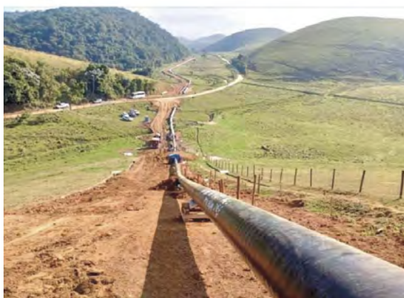
Fig. 12 - Os dutos enterrados são protegidos por sistemas de proteção catódica por corrente impressa, de acordo com a ABNT NBR ISO15589-1 (Proteção Catódica de Dutos Terrestres). Já as tubulações submersas no mar são protegidas com anodos galvânicos de Alumínio (ABNT NBR 10387) do tipo abraçadeira ou bracelete.
