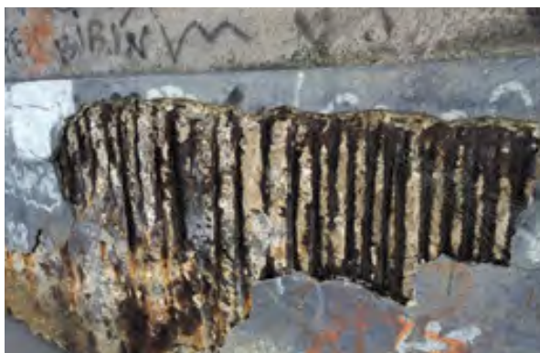
Fig. 16 – Armaduras de aço de estruturas de concreto, em especial quando contaminadas por cloretos e/ou CO 2 , sofrem sérios problema de corrosão que somente podem ser totalmente eliminados com a instalação de anodos de proteção catódica, do tipo galvânico ou por corrente impressa, de acordo com a ISO12696 (Cathodic Protection of Steel in Concrete), NACE SP0290 (Impressed Current Cathodic Protection of Reinforcing Steel in Atmospherically Exposed Concrete Structures) e NACE SP0408 (Cathodic Protection of Reinforcing Steel in Buried or Submerged Concrete Structures). As medições dos potenciais armadura/concreto e o consequente diagnóstico das regiões com maior ou menor probabilidade de corrosão, devem ser feitos de acordo a ASTM C876 (Standard Test Method for Corrosion Potentials Uncoated Reinforced Steel in Concrete).
