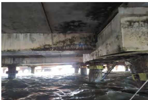
Fig. 16 – Armaduras de aço de estruturas de concreto, em especial quando contaminadas por cloretos e/ou CO 2 , sofrem sérios problema de corrosão que somente podem ser totalmente eliminados com a instalação de anodos de proteção catódica, do tipo galvânico ou por corrente impressa, de acordo com a ISO12696 (Cathodic Protection of Steel in Concrete), NACE SP0290 (Impressed Current Cathodic Protection of Reinforcing Steel in Atmospherically Exposed Concrete Structures) e NACE SP0408 (Cathodic Protection of Reinforcing Steel in Buried or Submerged Concrete Structures). As medições dos potenciais armadura/concreto e o consequente diagnóstico das regiões com maior ou menor probabilidade de corrosão, devem ser feitos de acordo a ASTM C876 (Standard Test Method for Corrosion Potentials Uncoated Reinforced Steel in Concrete).
