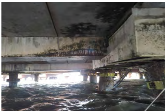
Fig. 16 – Armaduras de aço de estruturas de concreto, em especial quando contaminadas por cloretos e/ou CO 2 , sofrem sérios problemas de corrosão que somente podem ser totalmente eliminados com a instalação de anodos de proteção catódica, do tipo galvânico ou por corrente impressa, de acordo com a ISO12696 (Cathodic Protection of Steel in Concrete), NACE SP0290 (Impressed Current Cathodic Protection of Reinforcing Steel in Atmospherically Exposed Concrete Structures) e NACE SP0408 (Cathodic Protection of Reinforcing Steel in Buried or Submerged Concrete Structures). As medições dos potenciais armadura/concreto e o consequente diagnóstico das regiões com maior ou menor probabilidade de corrosão, devem ser feitos de acordo com a ASTM C876 (Standard Test Method for Corrosion Potentials Uncoated Reinforced Steel in Concrete).
