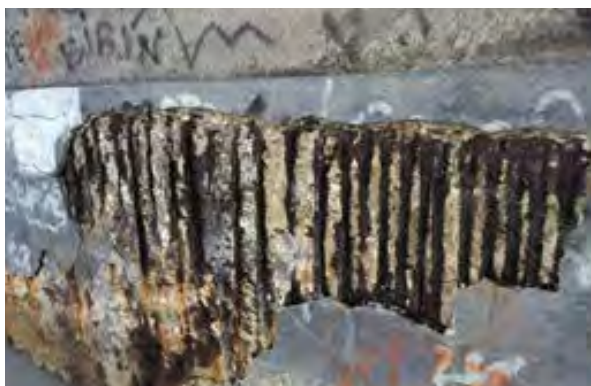
Fig. 16 – Armaduras de aço de estruturas de concreto, em especial quando contaminadas por cloretos e/ou CO 2 , sofrem sérios problemas de corrosão que somente podem ser totalmente eliminados com a instalação de anodos de proteção catódica, do tipo galvânico ou por corrente impressa, de acordo com a ISO12696 (Cathodic Protection of Steel in Concrete), NACE SP0290 (Impressed Current Cathodic Protection of Reinforcing Steel in Atmospherically Exposed Concrete Structures) e NACE SP0408 (Cathodic Protection of Reinforcing Steel in Buried or Submerged Concrete Structures). As medições dos potenciais armadura/concreto e o consequente diagnóstico das regiões com maior ou menor probabilidade de corrosão, devem ser feitos de acordo com a ASTM C876 (Standard Test Method for Corrosion Potentials Uncoated Reinforced Steel in Concrete).
