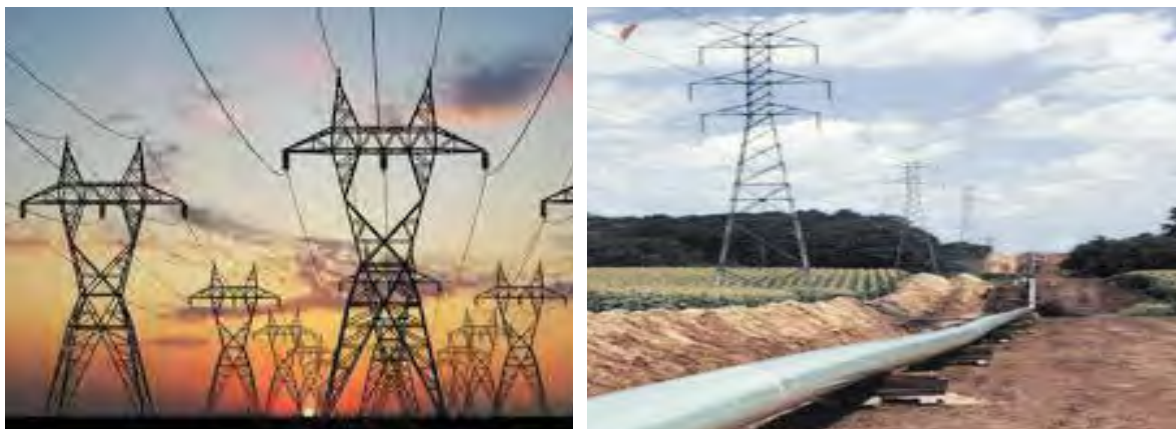
Fig. 14 – Quando tubulações metálicas enterradas cruzam ou se aproximam de linhas de transmissão elétrica em alta tensão aparecem problemas importantes de segurança das pessoas (tensões tubo/solo elevadas) e de corrosão por corrente alternada (corrosão AC), havendo necessidade de um estudo detalhado e cuidados para o dimensionamento, instalação, inspeção e manutenção do seu sistema de proteção catódica. Nesses casos as normas a serem atendidas são a ABNT NBR ISO15589-1 (Proteção Catódica de Dutos Terrestres) e a ABNT NBR ISO16563-1 (Mitigação de Efeitos de Interferências Elétricas em Sistemas Dutoviários Causados por Sistemas por Corrente Alternada).
