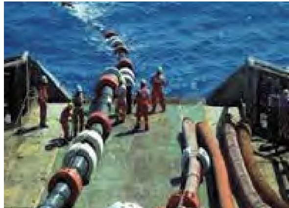
Fig. 12 - Os dutos enterrados são protegidos por sistemas de proteção catódica por corrente impressa, de acordo com a ABNT NBR ISO15589-1 (Proteção Catódica de Dutos Terrestres). Já as tubulações submersas no mar são protegidas com anodos galvânicos de Alumínio (ABNT NBR 10387) do tipo abraçadeira ou bracelete.
