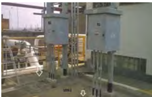
Fig. 15 – Tubulações enterradas em plantas industriais, como a redes de combate a incêndio, água de refrigeração, gás e outros produtos, estão sujeitas a problemas graves de corrosão devido, principalmente, à presença da malha de aterramento elétrico (par galvânico aço/cobre) e de correntes de interferência, necessitando sempre de um sistema de proteção catódica por corrente impressa, que nesses casos deve ser implantado em conformidade com a ABNT NBR 16896 (Proteção Catódica de Instalações Complexas).
