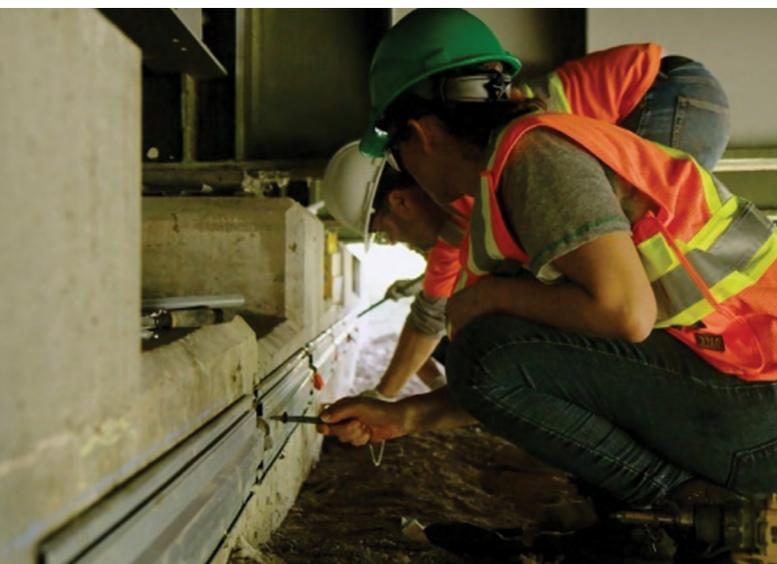
*Fig. 08 - Anodos galvânicos Galvashield SM-DAS em fase de instalação sobre a superfície e sem a necessidade de quebrar ou furar o concreto. A instalação é feita nos locais de corrosão ativa, identificados através das medições dos potenciais, ou nos locais onde o concreto foi recuperado mas os anodos XP ou DAS não foram instalados, por esquecimento ou por falta de tempo hábil.*
