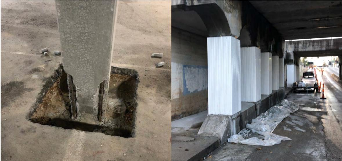
Fig. 10. Instalação do sistema de anodos e jaquetas Galvalume Jacket para a reabilitação de pilares de concreto fora do mar. Essa solução é definitiva e possui eficiência comprovada. A instalação dos anodos, também nesses casos, é a única maneira de garantir a recuperação das estacas de maneira prática, segura e econômica [4].
