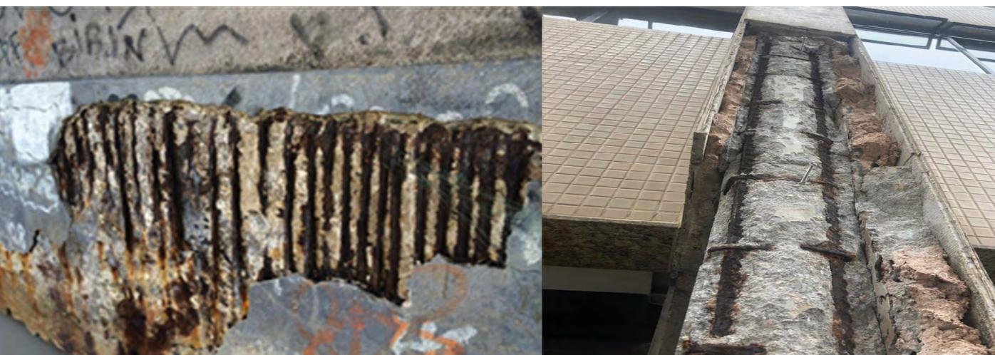
Fig. 01 – Dois exemplos de corrosão em armaduras, causada pela absorção de cloretos. Nesses casos os serviços de reabilitação precisam ser complementados com a instalação dos anodos galvashield de proteção catódica, única maneira de evitar que a corrosão volte com força total [8].
