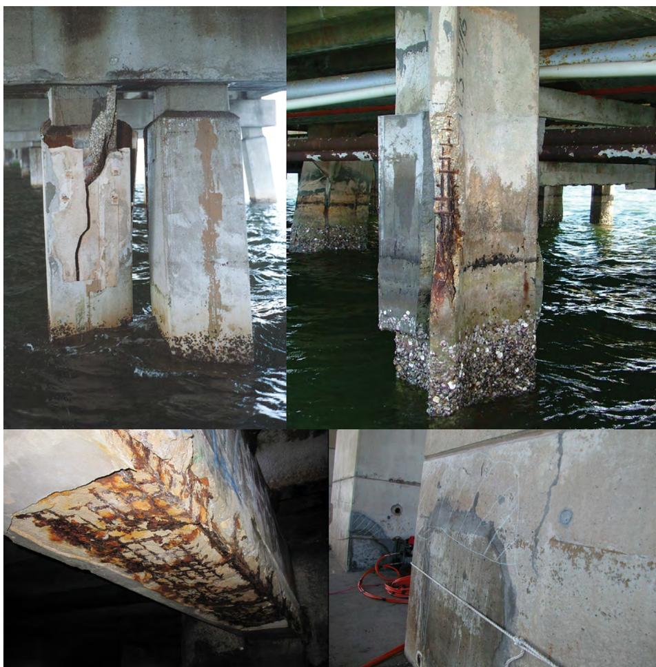
Fig. 03 - Quatro exemplos de estruturas de concreto contaminadas por cloretos, que experimentaram serviços de reabilitação sem a instalação dos anodos, e onde a corrosão voltou com força total, em muito pouco tempo. Serviços de reabilitação e recuperação nessas condições somente são eficientes e definitivos se executados com a instalação dos anodos.
