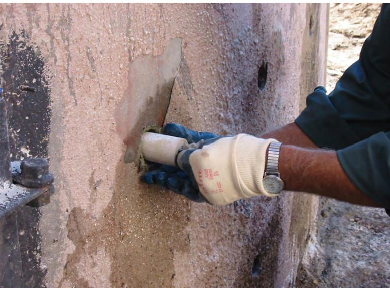
*Fig. 07 - Instalação de anodos galvashield CC em pilar de viaduto, embutidos em furos, sem a necessidade de quebrar o concreto, para eliminar a corrosão das armaduras nos locais onde as medições dos potenciais indicaram a presença de corrosão ativa. Essa é uma solução eficiente e definitiva para um problema muito comum de ocorrer em pontes e viadutos de um modo geral. Nesses casos, não devemos esperar que a corrosão aflore e exija serviços onerosos de reabilitação.*
