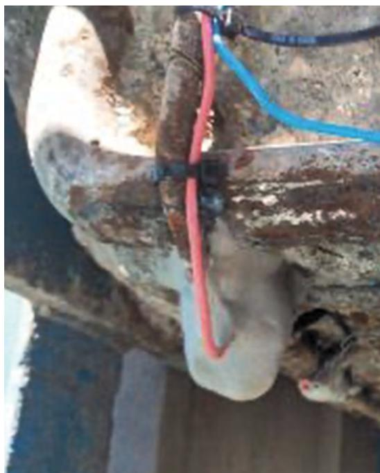
Figura 8 Exemplo de campo, onde a conexão foi revestida com massa epóxi.
