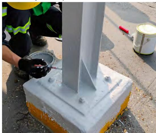
Revestimento executado com Borracha líquida + Manta geotêxtil + selador epóxi (na base de concreto)
