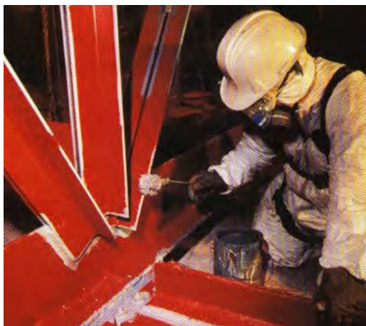
O pintor improvisou uma “ferramenta” para aplicação do “stripe coat”. Antes isto do que nada (2)
