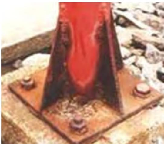
Figura 2 - Corrosão em arestas vivas nas abas de uma coluna
