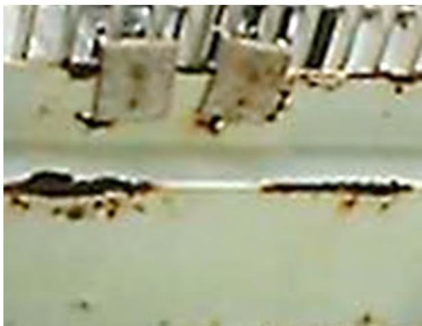
Figura 3 - Corrosão nas arestas vivas em uma Viga de aço
