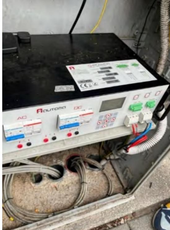
Fig. 1 Retificador Inteligente de Proteção Catódica (Fonte: Automa Srl.)
