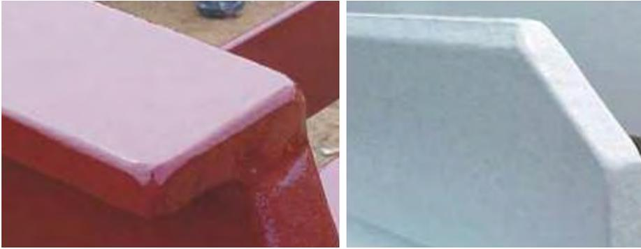
Figura 15 - Estruturas pintadas com as bordas arredondadas (maior vida útil sem corrosão) (7)
