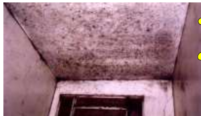
Pintura com tinta inadequada: Teto com mofo
