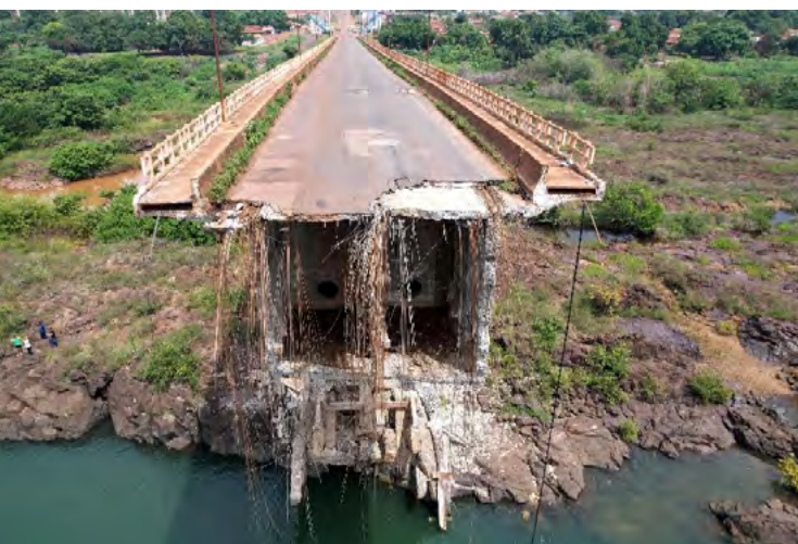
Figura 2 - Ponte Juscelino Kubistchek após colapso da estrutura [5]
