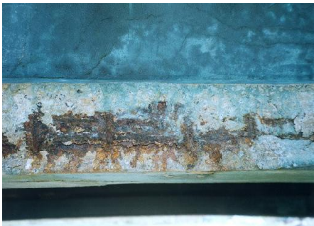
Figura 03 – Viga de concreto armado com exposição de armadura com corrosão severa.
