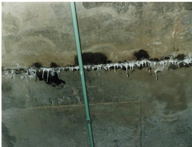
Figura 04 – Laje de concreto com presença manchas de eflorescências e com formação de estalactites resultantes da lixiviação de compostos do cimento e de sua reação química com o CO 2 atmosférico e com a presença de manchas de umidade resultante dessa reação química e de possível infiltração de água pela junta.
