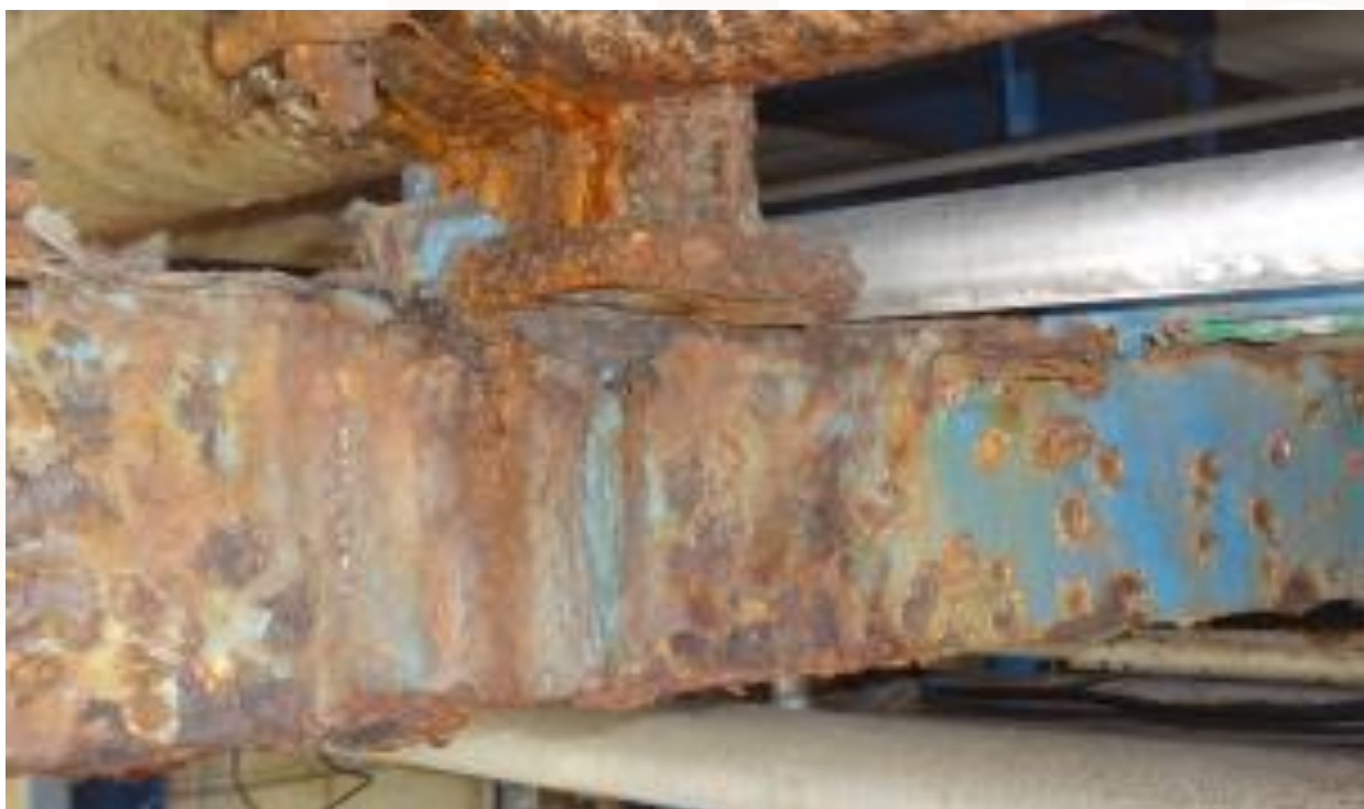
Pintura com Deterioração Completa e Perda de Material
