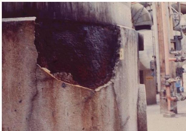
Fig.08 - Corrosão sob revestimento com concreto para proteção passiva corta fogo (Cortesia IEC Engenharia)
