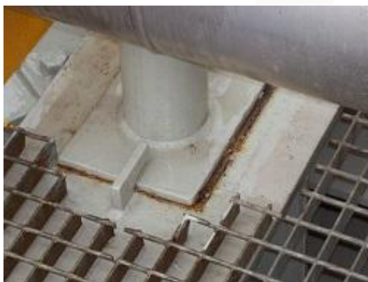
Fig.01 - Apoio de estrutura (Cortesia IEC Engenharia)
