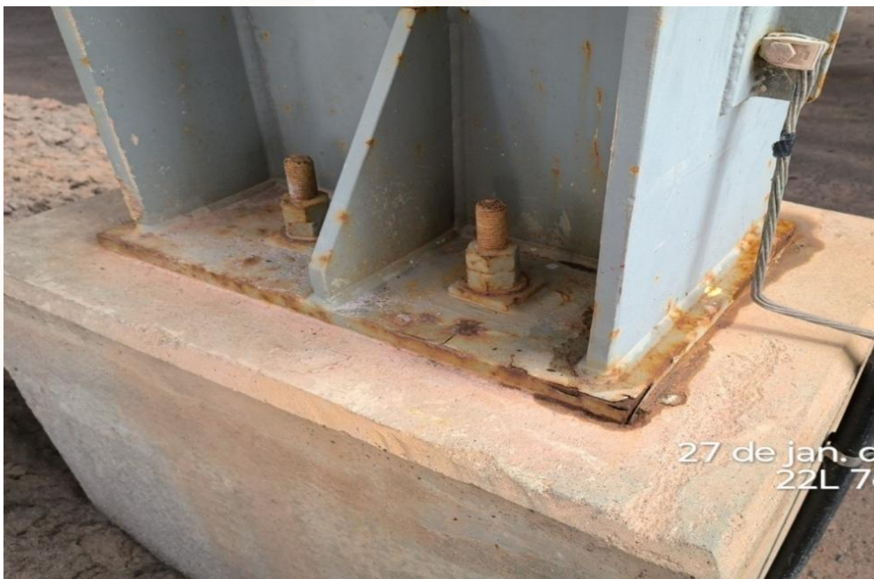
Pintura com Início de Falha
