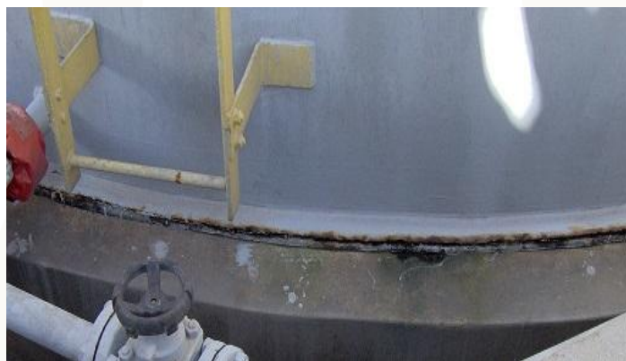
Fig. 02 - Base de tanque de armazenamento (Cortesia IEC Engenharia)
