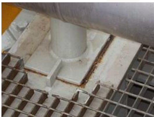
Fig.01 - Apoio de estrutura (Cortesia IEC Engenharia)
