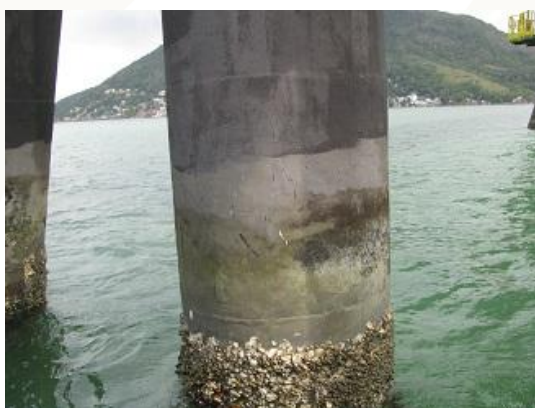
Fig. 06 - Zona de variação de nível (Cortesia IEC Engenharia)
