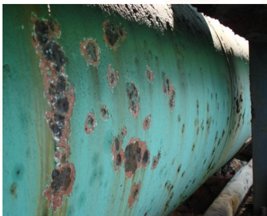
Fig. 07 - Reparo de campo em pintura de tubulação com pites/alvéolos (Cortesia HITA/Belzona)
