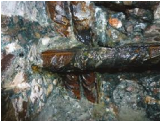
Figura 5 - Corrosão negra. Fonte: (11)
