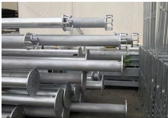
Fig. 01 - Estrutura metálica tubular (pilares do Museu de Arte do Rio)
