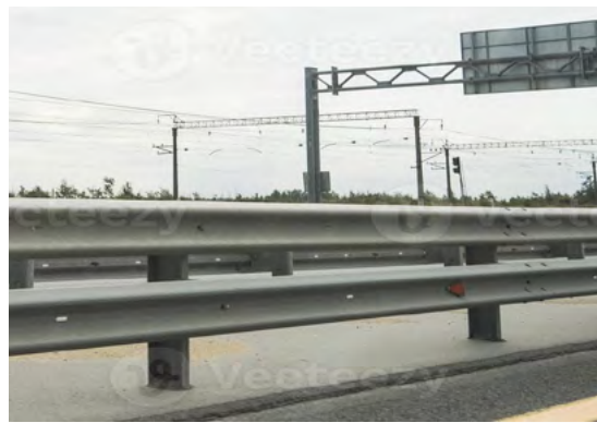
Fig. 02 - Equipamentos públicos - guarda-corpo em rodovias
