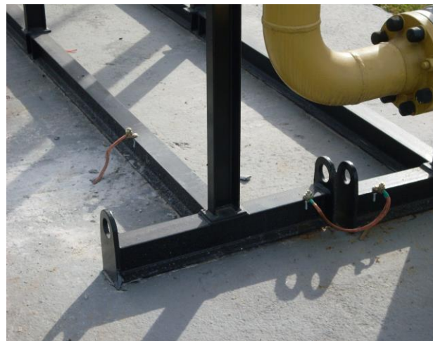
Figura 4 - Interligação dos skids
