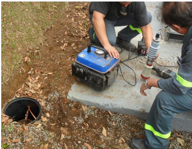
Figura 1 - Instalação de isoladores
