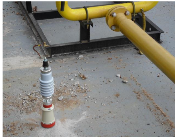
Figura 2 - Isolador instalado
