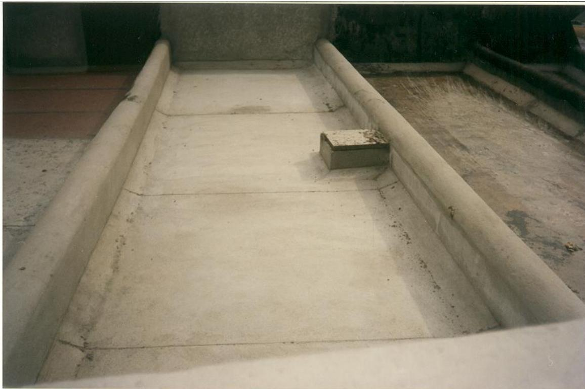
**Figura 3-Manta asfáltica aplicada em marquise do estádio machadão com proteção mecânica**
