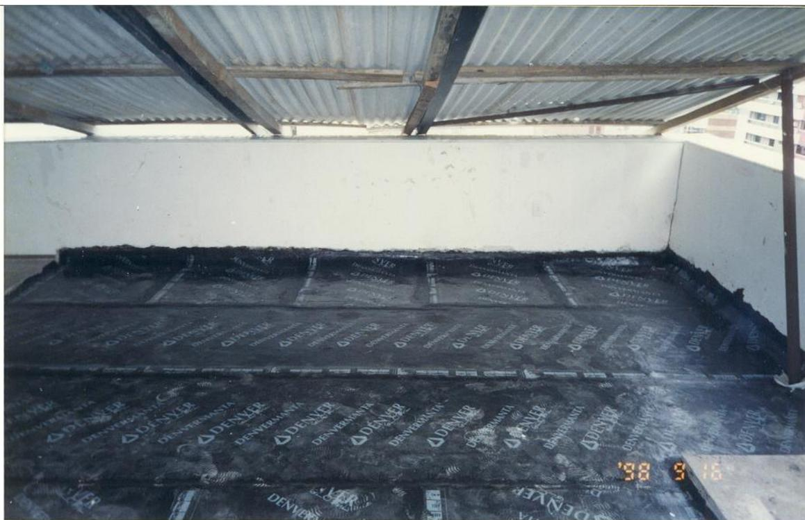
**Figura 1-Manta asfáltica aplicada em laje de piso do último pavimento de condomínio após colapso estrutural da laje da cobertura**
