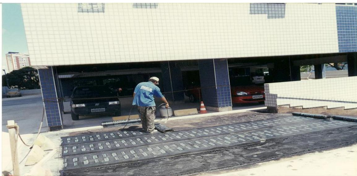
**Figura 2-Aplicação de manta asfáltica em lajes de piso(garagens) e rampa de acesso do condomínio**
