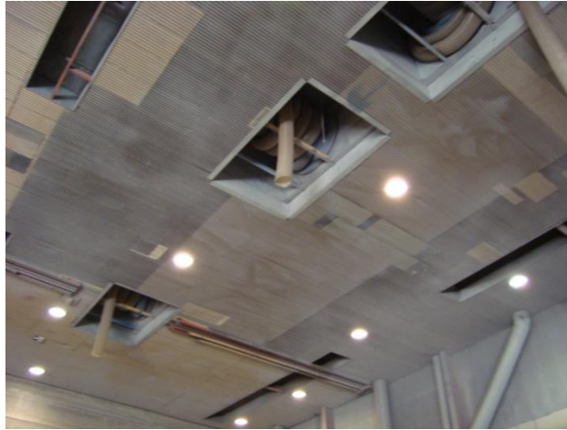
Figura 5 - Oficina equipada com filtros
