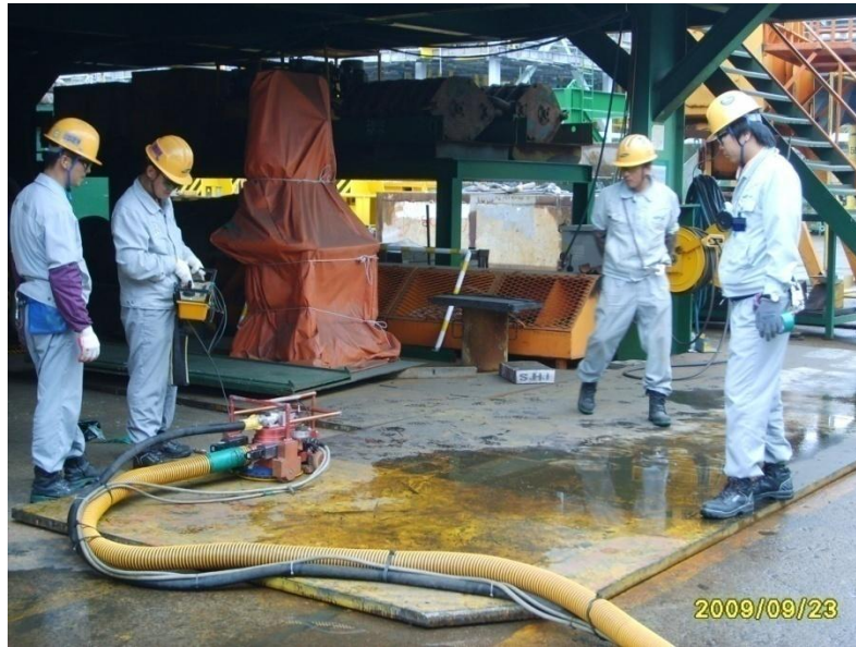
Figura 2 – Unidade de injeção de abrasivo
