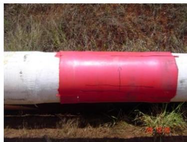
Figura 2 – Junta aplicada por IMPE e junta aplicada por IMPP.
