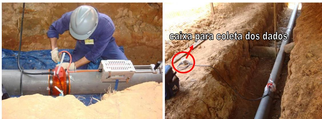
**Figura 21** - Imagens obtidas durante e após a instalação dos colares de monitoração por ondas guiadas. Em destaque (círculo e seta) é mostrada a caixa de coleta dos dados.
