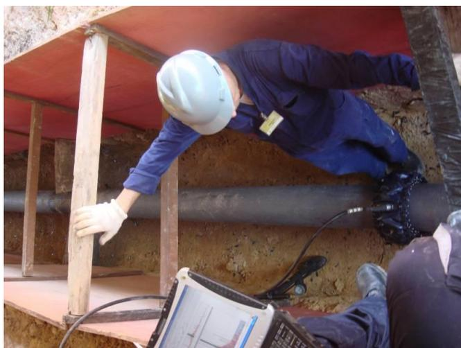
**Figura 20** - Imagem obtida durante a inspeção por ondas guiadas.
