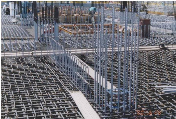
Ilustración 6: Posicionamiento del Refuerzo
