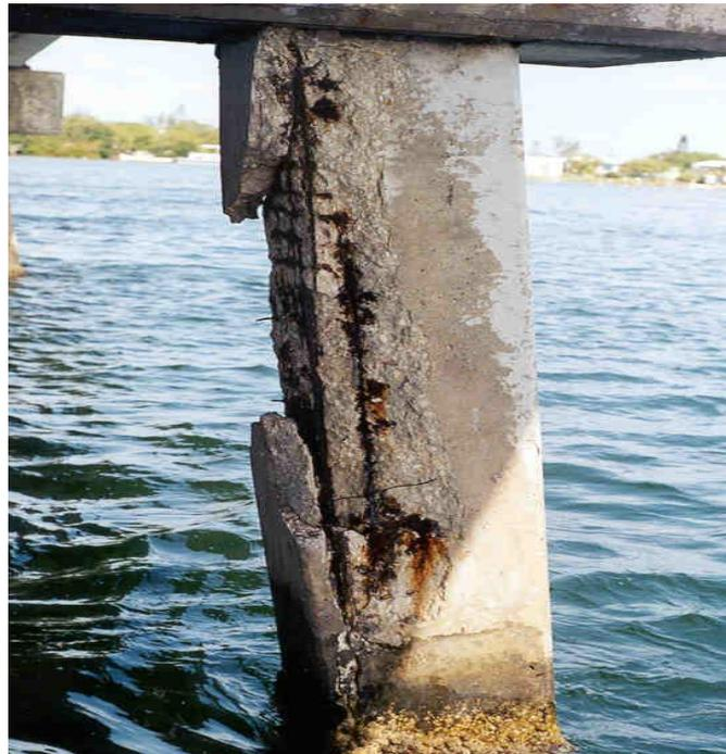
Ilustración 11: Ejemplo de acero expuesto
