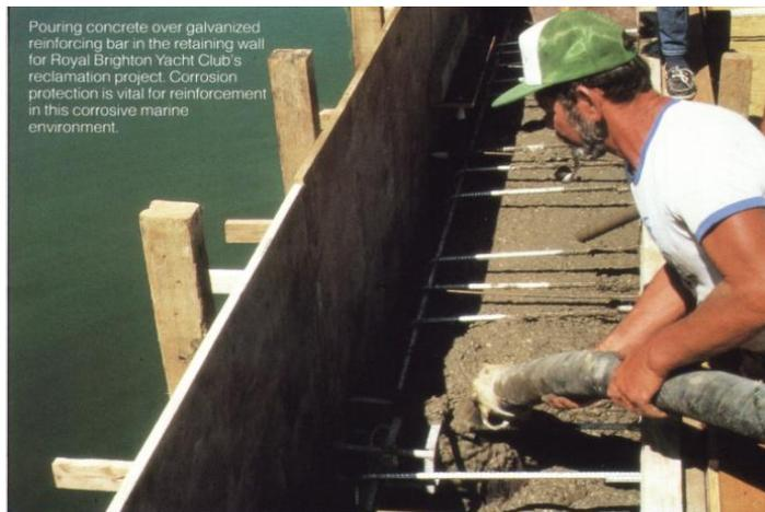
Ilustración 7: Colado del Concreto
