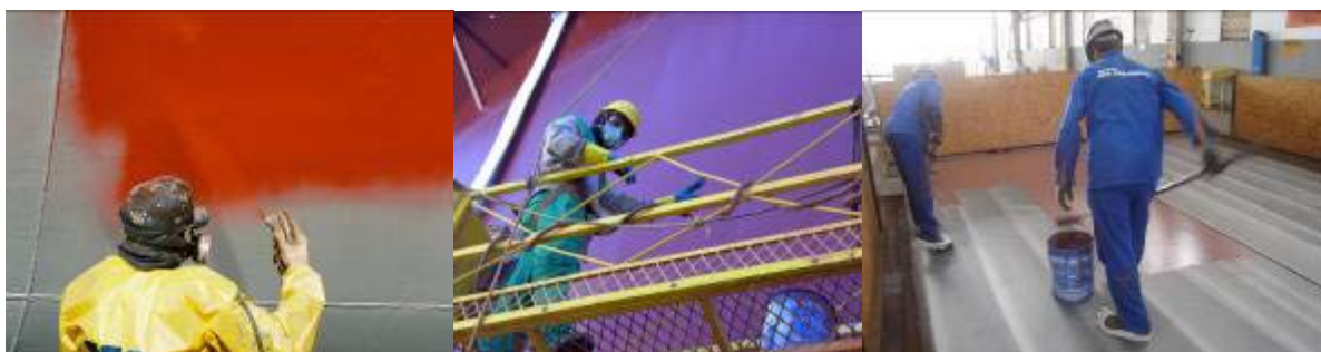
Figura 3 - Aplicação das tintas em campo
