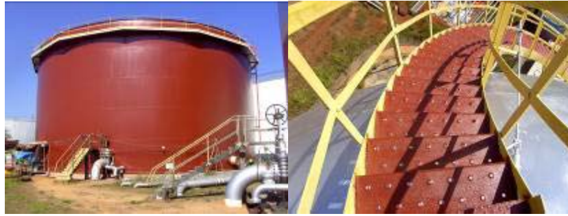
Figura 8 - Tanque (externo) e estruturas metálicas
