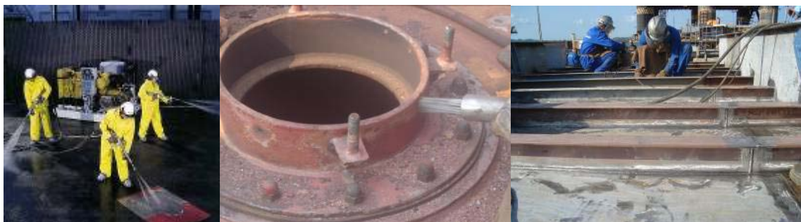
Figura 2 - Tratamento de superfície
