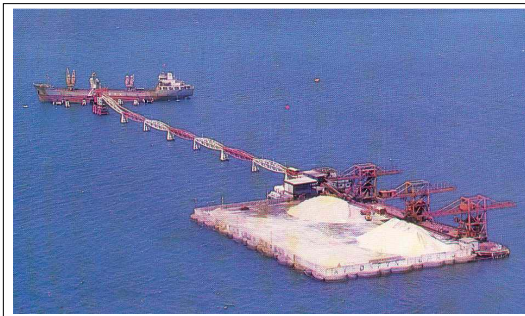
Figura 1 – Vista aérea do Terminal, antes da sua ampliação
