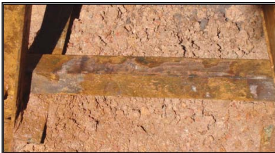
Figura 9 – Aspecto visual das grelhas da torre 404 da LT 230 kV Rondonópolis/Coxipó, após escavação de 1,5 m. Detalhe do perfil da base da parte desenterrada da estrutura
