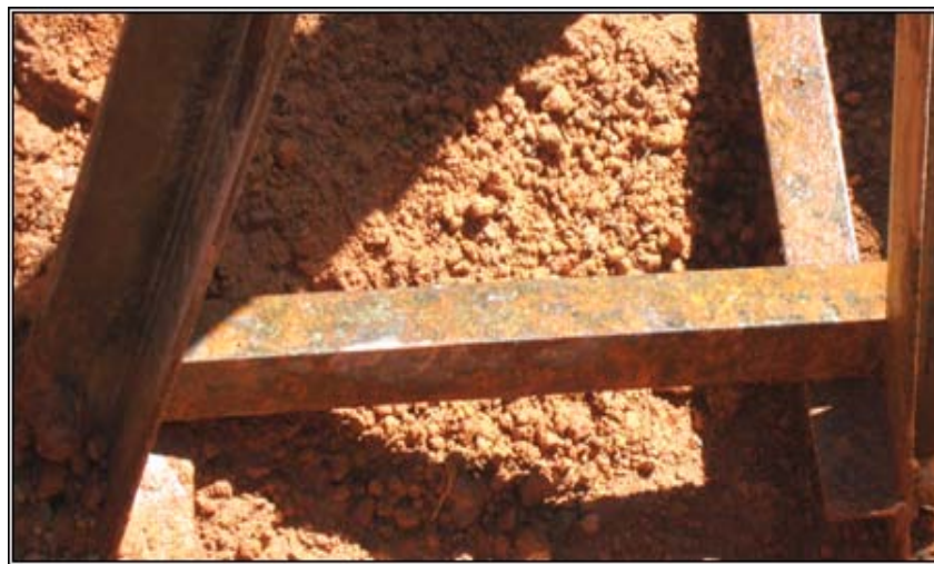
Figura 7 – Aspecto visual das grelhas da torre 102 da LT 230 kV Rondonópolis/Coxipó, após escavação de 1,5 m. Detalhe do perfil da base da parte desenterrada da estrutura
