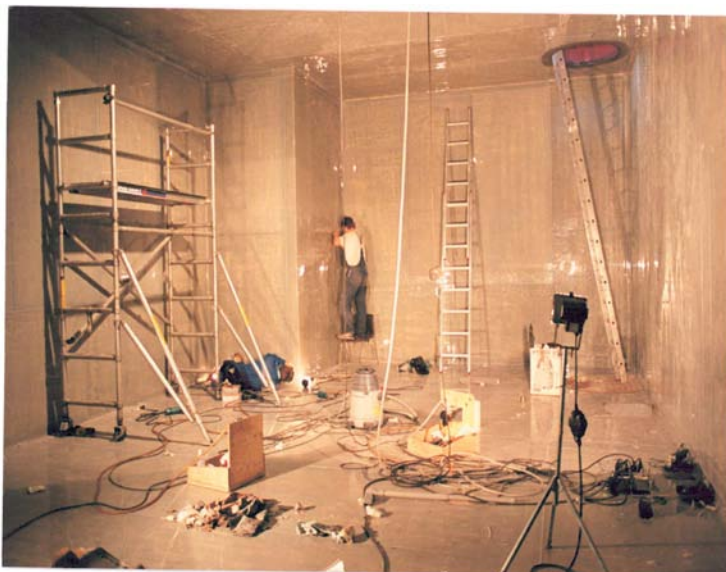
Figura 22: Aplicação das chapas de ECTFE em tanque de navio para transporte de químicos.
