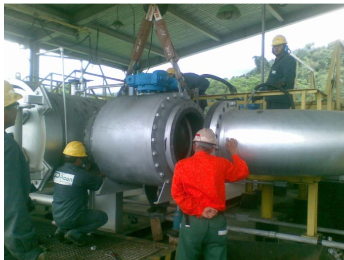
Figura 19. Montagem da válvula no sistema.
