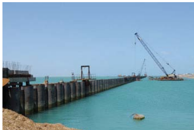
Figura 1 – Detalhe da cortina metálica
