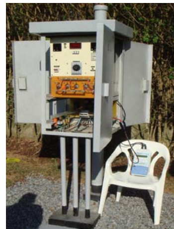
Figura 6 – Registros fotográficos do site de treinamento: a) faixa do duto enterrado e b) retificador de proteção catódica.
