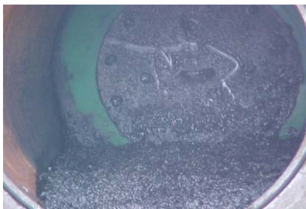
Figura 2 – Resíduo arrastado por um pig de limpeza [3].
