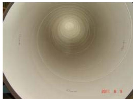
Figura 10 – Tubo revestido após cura total
